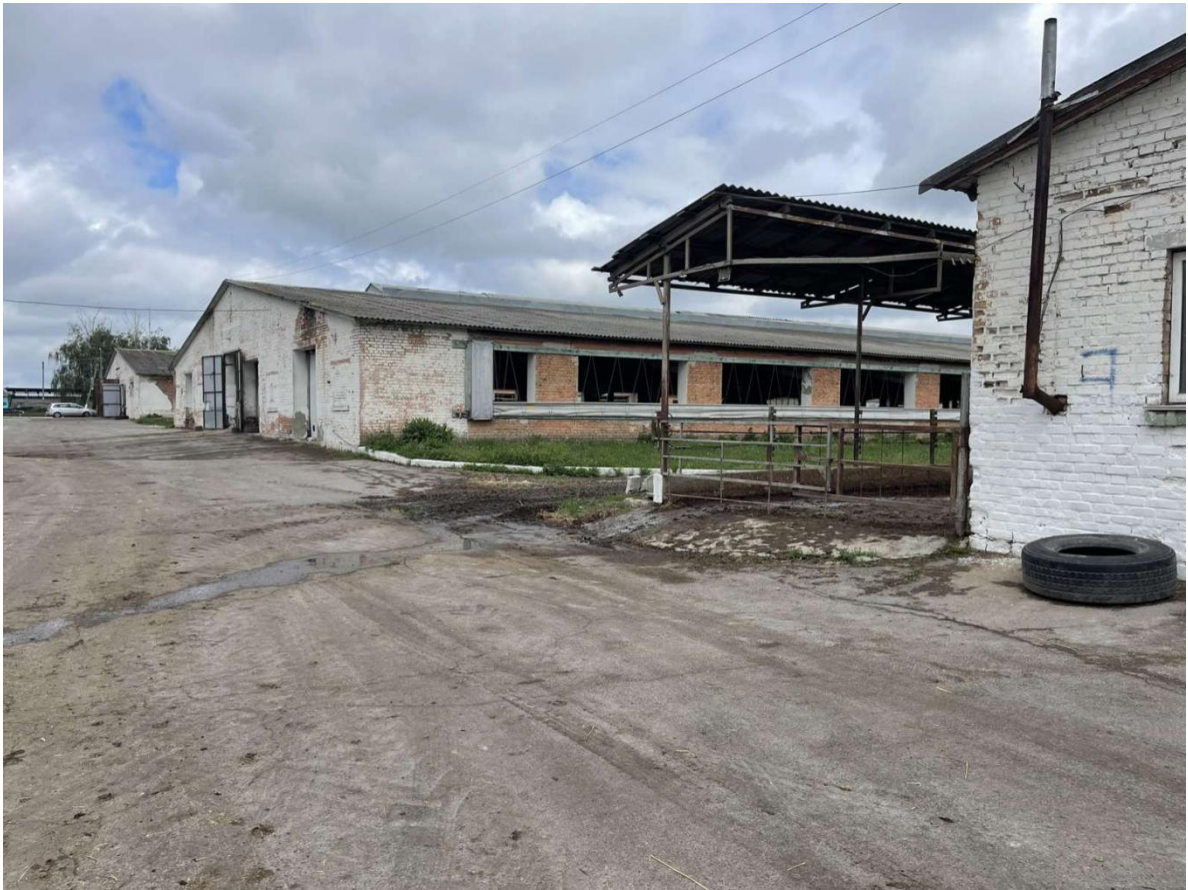
Рис. 3.1.2 – Загальний вигляд приміщень
