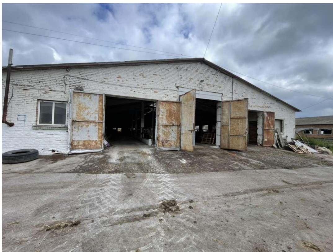
Рис. 3.1.1 – Загальний вигляд приміщень
