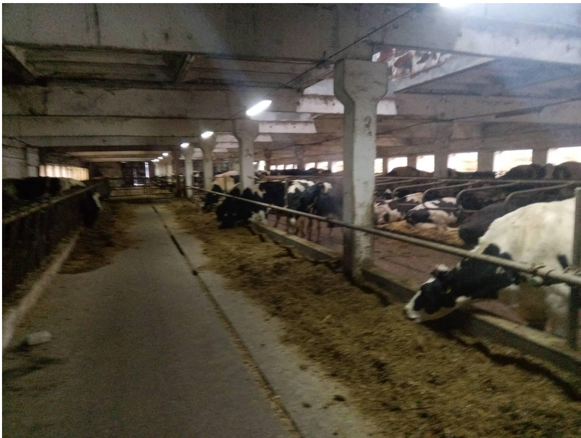
Рисунок 3.2.2. Внутрішній вигляд приміщення.
