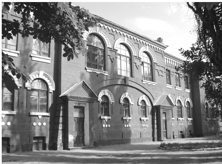
Центральний корпус Олександрійського аграрного технікуму
