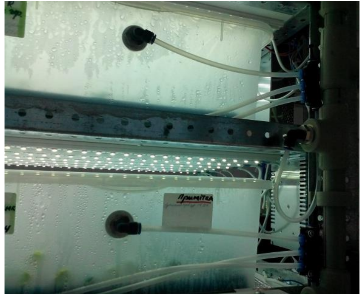
Контейнери із газопроводами
