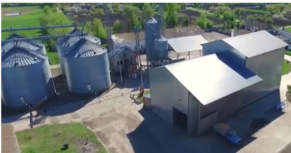
Рис.3.1. Комбікормовий міні-завод ТДВ «Терезине»
