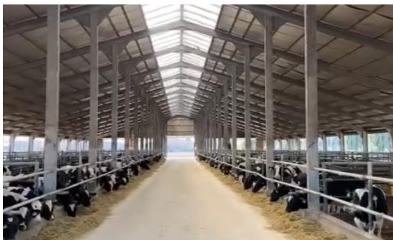
Рис.3.2. Приміщення для утримання корів
