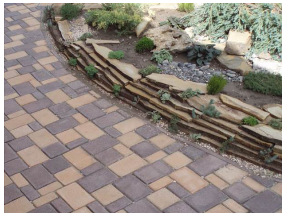
Рис. 7. Приклад мощення садових доріжок у парку та обмеження периметру клумби плитками пісковика.
