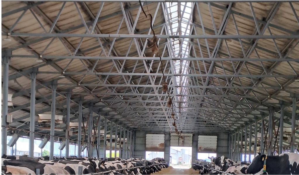
Рис. 7. Спеціальна конструкція конька покрівлі.
