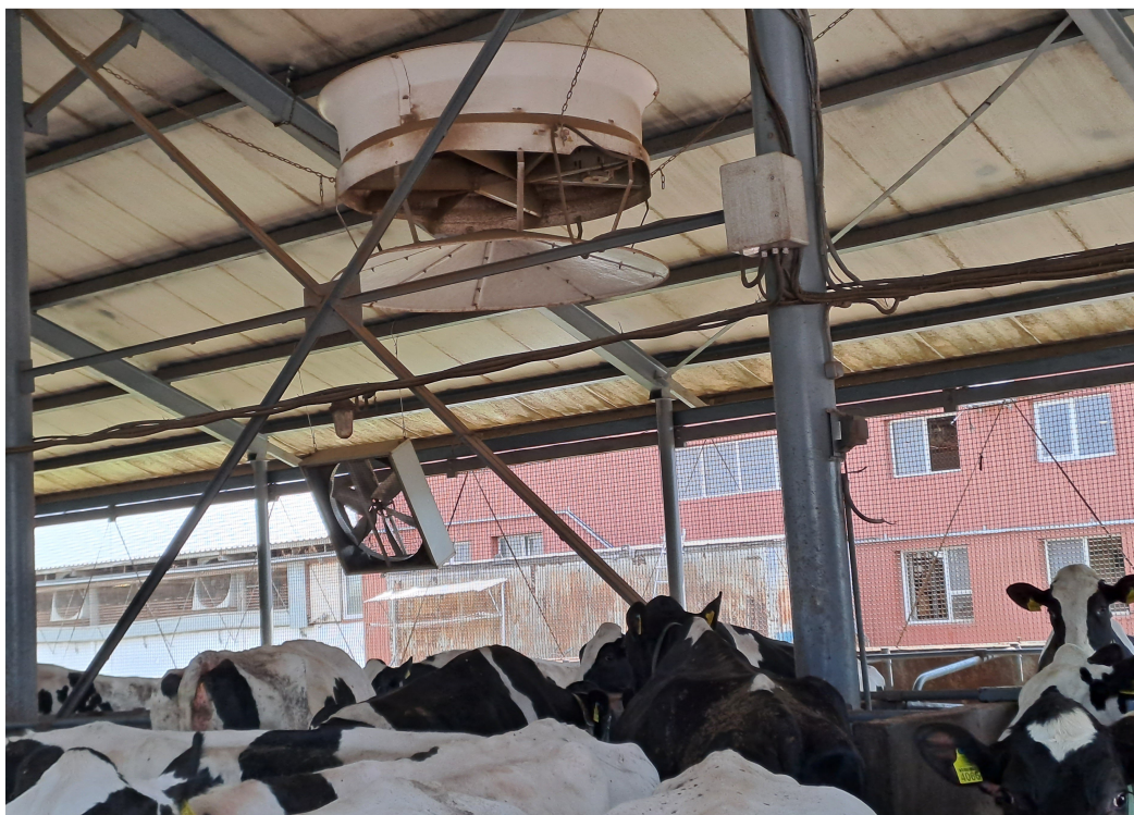
Рис. 6. Вентилятори для перемішування повітря у приміщенні
