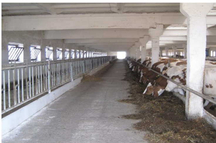
Рис. 1. Реконструйоване приміщення для утримання корів.
