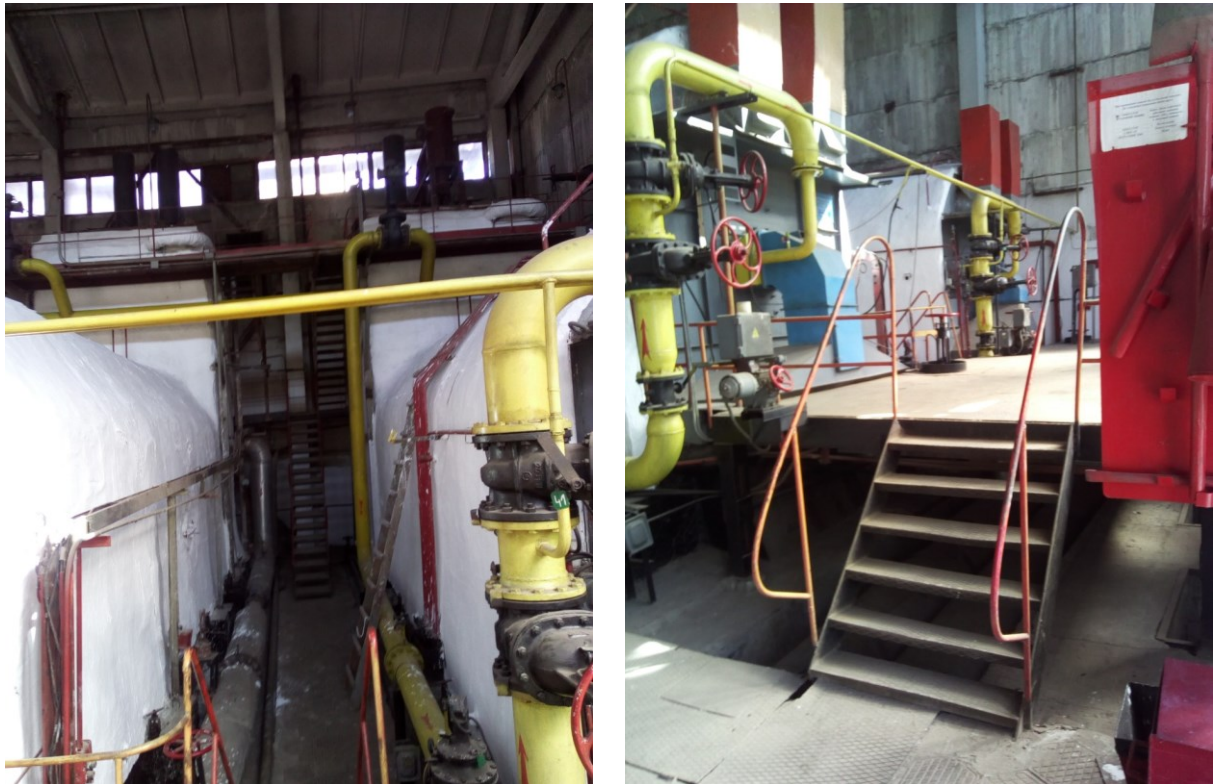
Рис.2.2. – Переобладнані паливні котли КП "Теплокомуненерго"
