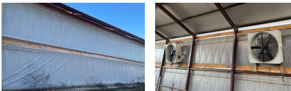
Рис. 3.4. Шторна система і вентилятори у ТОВ «Джет»
