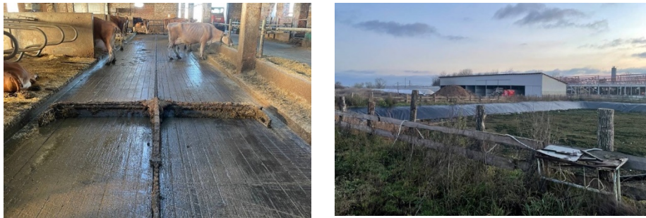
Рис. 3.5. Скреперна система і гноєнакопичувальна лагуна у ТОВ «Джет»
