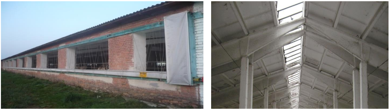
Рис. 3.4. Світлоаераційний дашок та бокові штори.
