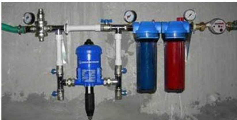
Рис.1 – Ємності для розчину лимонної кислоти та системи подальшого водопостачання
