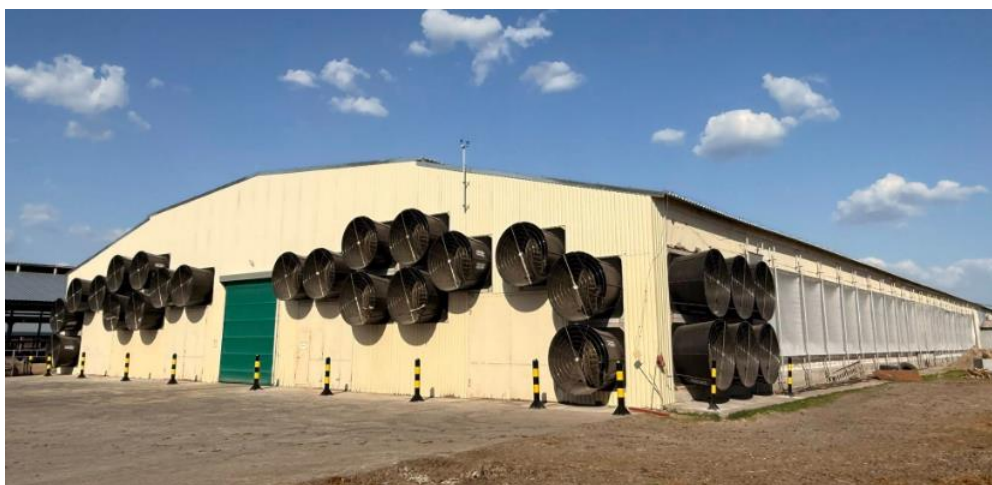
Рис. 3.2. Система вентиляції у корівнику
