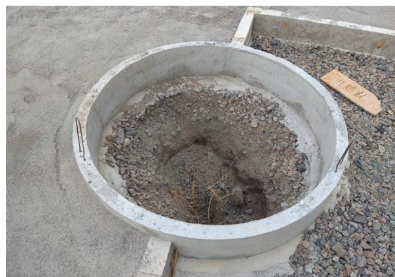
Рис. 8. Кільце з/б під пристовбурову решітку.
