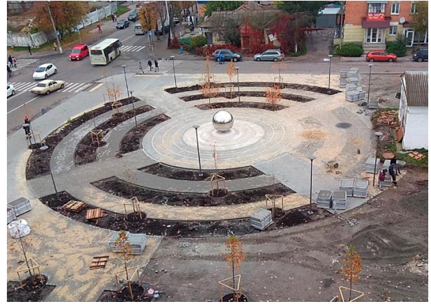
Рис. 10. Загальний вигляд площі в процесі виконання робіт.
