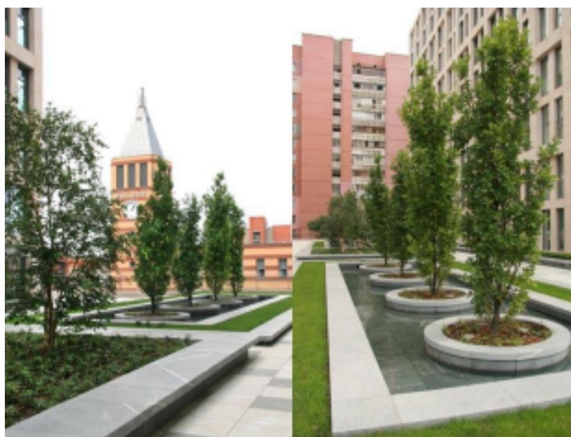
Рис. 3. Зелений дах інтенсивного типу на торговельному центрі «Каскад Плаза», м. Дніпро Фото: ZinCo Україна, flickr-users Niall Kennedy , Steve Perry , Ana Fuentes
