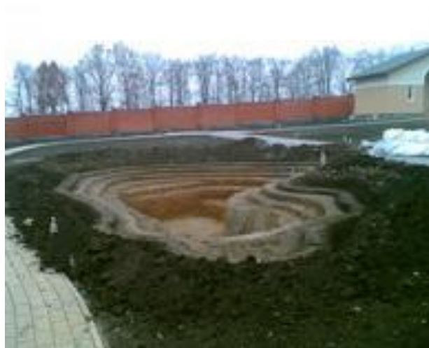
Рис. 3.2. Формування профілю водойми
