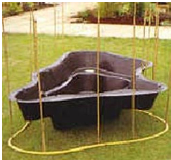
Рис. 3.1. Намічаємо контури водойми
