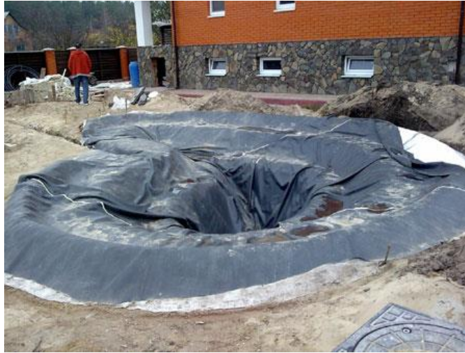
Рис. 3.3. Укладання плівки
