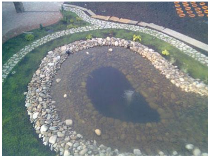
Рис. 3.4. Заповнення котловану водою і обрізання плівки.
