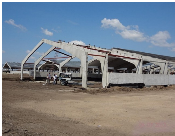
Рис. 4.4.1. – Початок будівництва свинокомплексу
