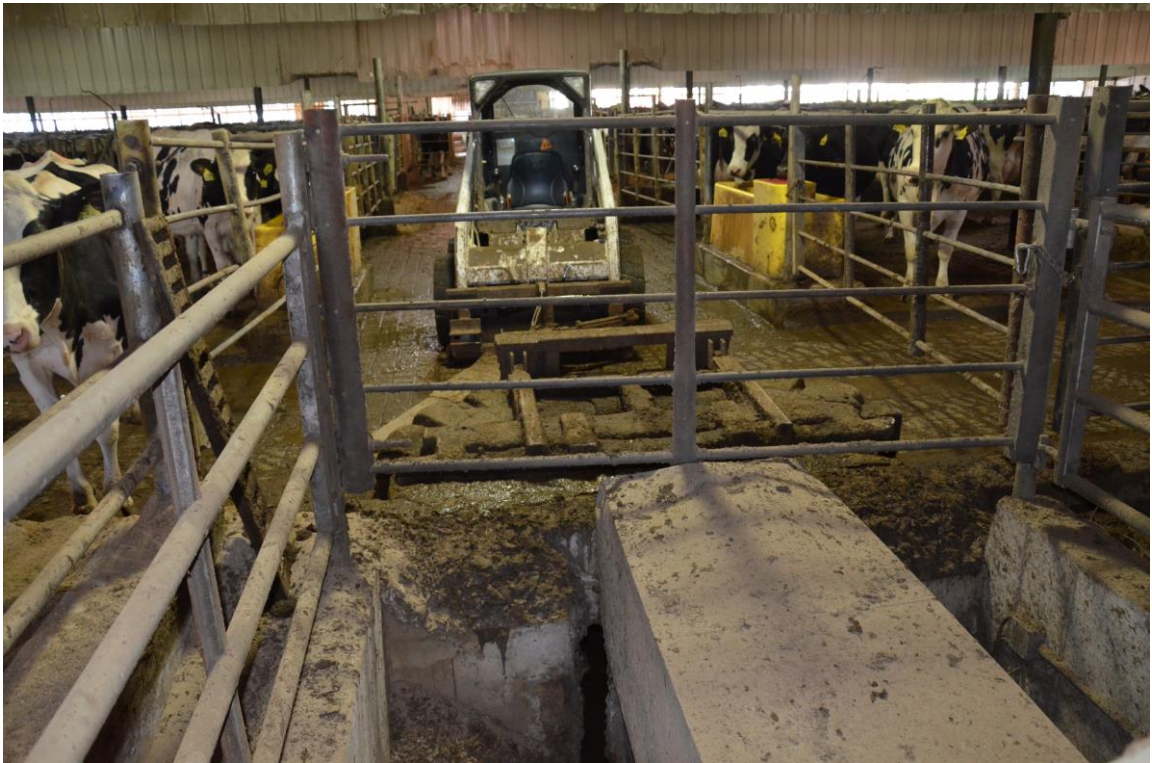
Рис. 2.1.3.6. Видалення гною за допомогою мобільного засобу в приймальний бункер по центру ферми (центральний поперечний канал).
