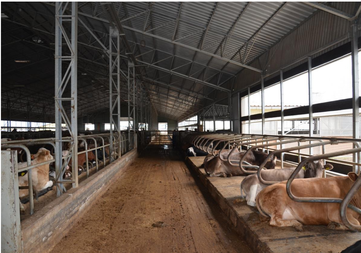
Рис. 2.1.2.6. Компонівка одинарних боксів у чотирирядному корівнику.
