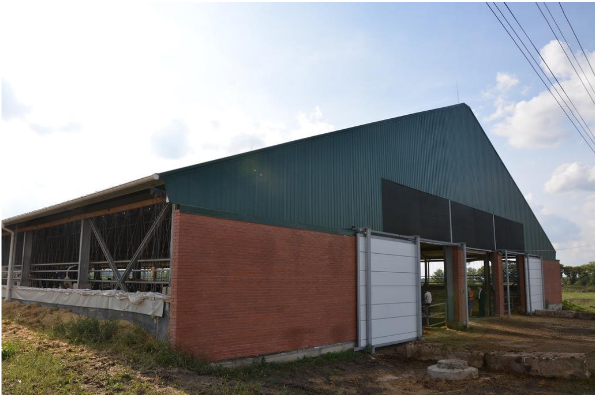
Рис. 2.2.25. Вентиляція приміщень із використанням світлоаераційних штор у корівнику з накопичувальною підстилкою (ТОВ «Кишенці»).
