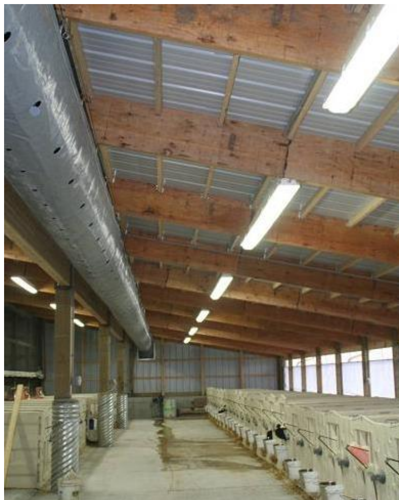
Рис. 2.1.3.11. Обладнання приміщення для телят з примусовою вентиляцією (поліетиленовий рукав); («Rosy-Lane»).
