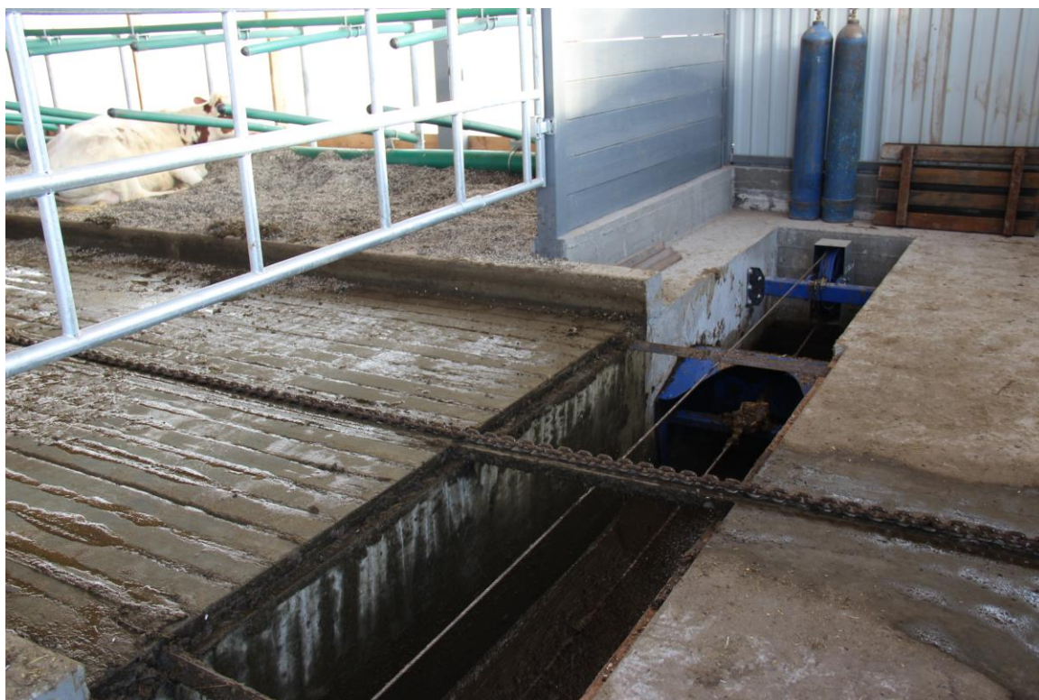
Рис. 2.1.2.28. Поперечний канал для видалення гною із застосуванням системи «Кросс Гаттер» фірми «Де Лаваль» (МК «Перемога Батькова»).
