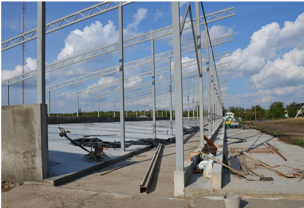
Рис. 2.2.22. Фрагмент будівництва напіввідкритого приміщення для утримання телиць на накопичувальній підстилці (ТОВ «Кишенці» Маньківського р-ну Черкаської обл.; директор Корнеліс Хузінга).
