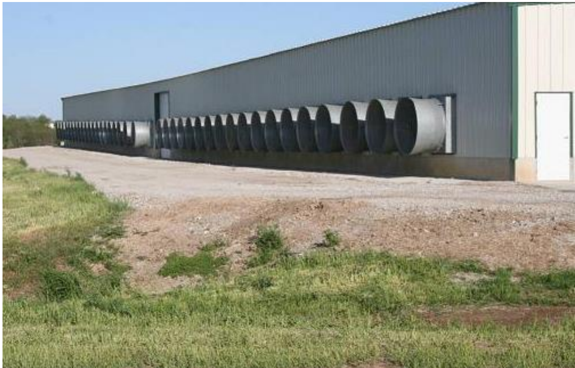
Рис. 2.1.3.7. Вигляд приміщення збоку вентиляційних шахт. Видно проектувальне рішення з нахилом до центру будівлі, де розташована система видалення гною.
