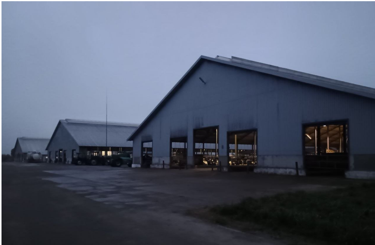
Рис. 2.2 – Приміщення молочно-товарної ферми ТДВ «Терезине».
