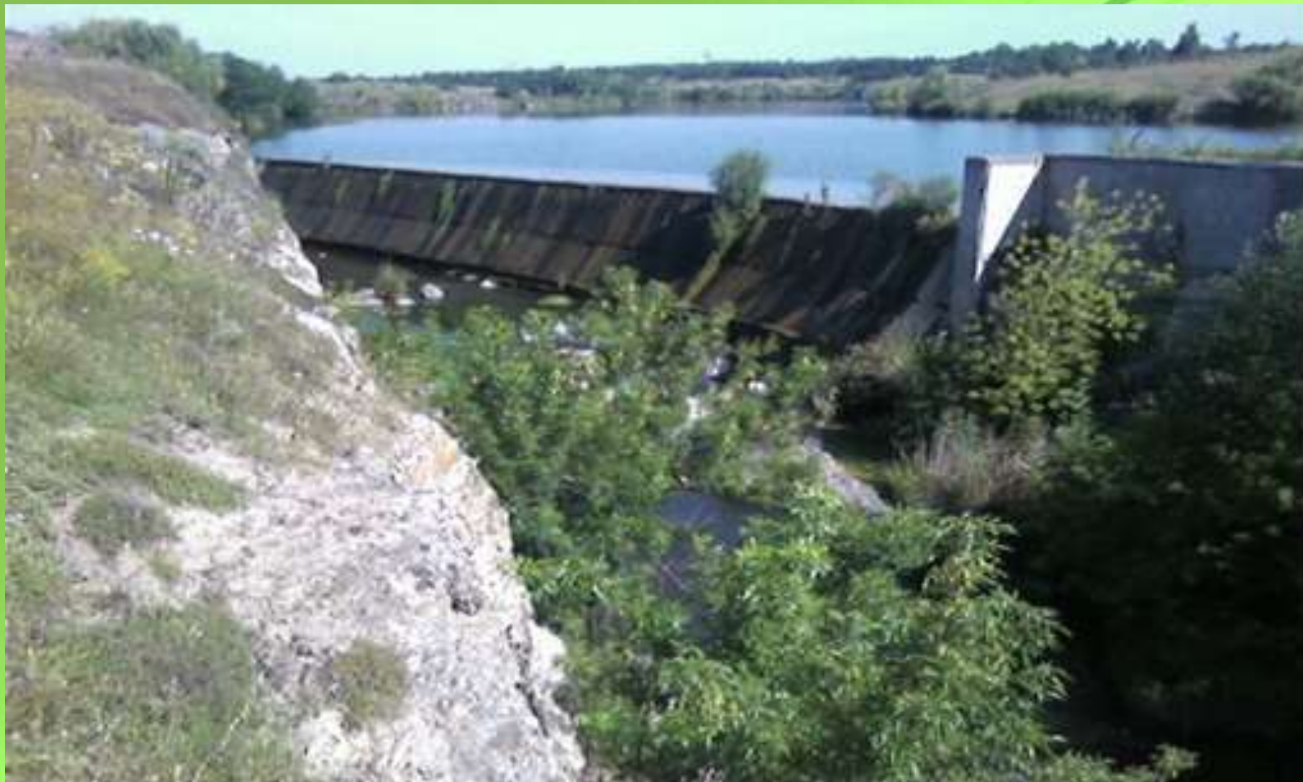
Водозабірна споруда на річці Сугоклеї
