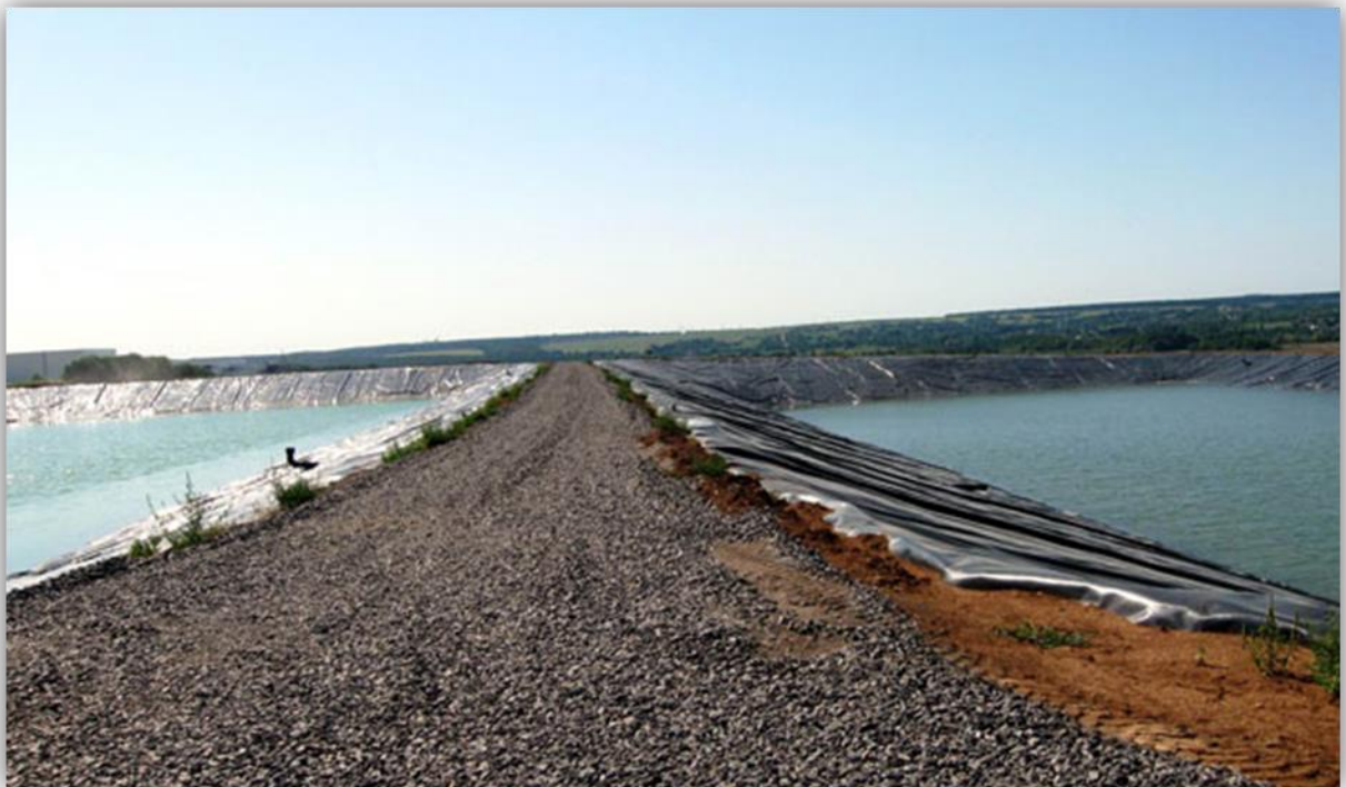
Рис. 3.5. Накопичувальні резервуари на біологічних очисних спорудах
